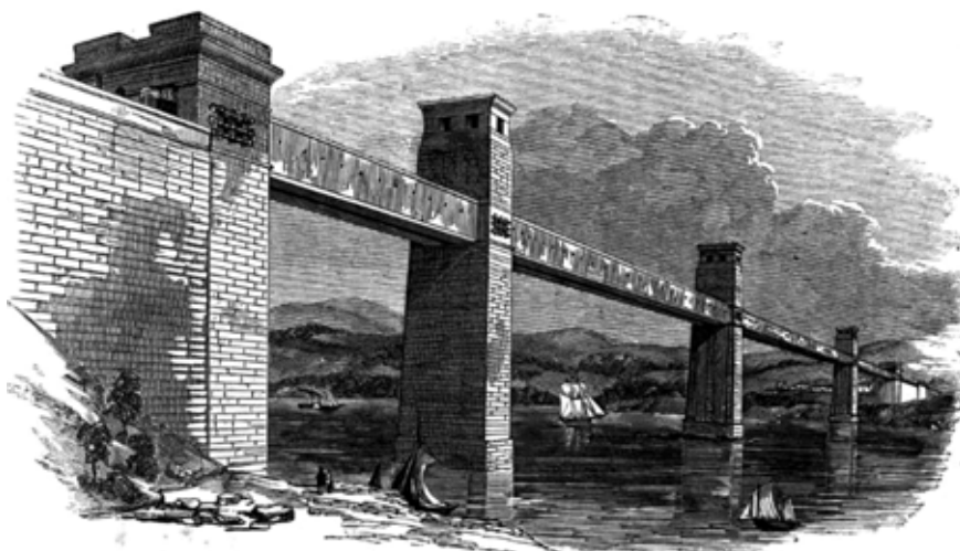
Fot. 4. Rurowy (tubularny) most Britannia przez cieśninę Menai Strait w Walii, zaprojektowany przez Roberta Stephensona, długość głównych przęseł 140 m, 1850 r.
