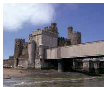
Fot. 3. Rurowy (tubularny) most przez rzekę Conwy w Walii, zaprojektowany przez Roberta Stephensona, długość przeszła 125 m, 1849 r.
